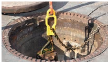
Heben von Pumpen mittels Pumpengreifstück
